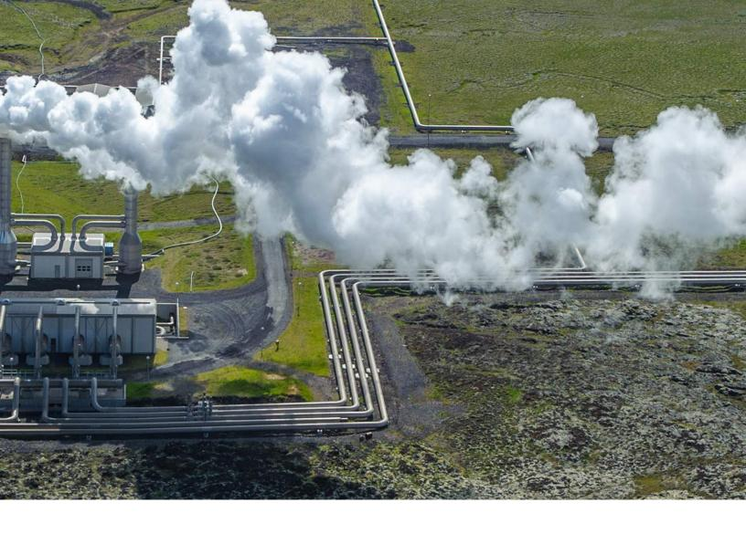
L'eau est surchauffée jusqu'à ce qu'elle se transforme en fluide thermodynamique, qui fait tourner un générateur, qui à son tour produit l'énergie. Suivant ce processus, l'eau est retournée dans le réservoir géothermique, pendant que l'air refroidit le fluide thermodynamique avant de repasser par l'échangeur de chaleur. L'électricité produite est intégrée au réseau électrique pour être utilisée par les consommateurs.
